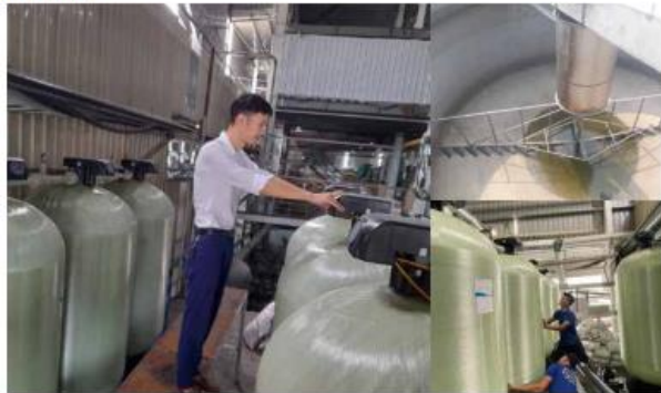
Hệ thống lọc nước phục vụ sản xuất nước làm mát, rửa kính ô tô Maxxi KCN Hoàng Đông, Hà Nam
