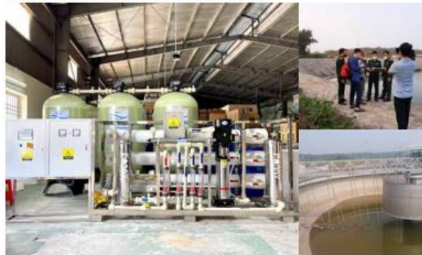
Hệ thống lọc nước RO công suất lớn cho phục vụ cho toàn bộ nhân dân và cán bộ chiến sĩ huyện đảo Bạch Long Vĩ
